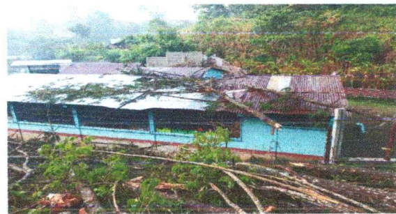
Foto 6: Se observa todo el modulo que necesita techo nuevo
